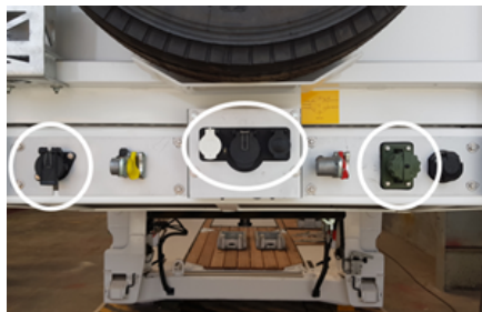
Effectuer les raccords électriques.
