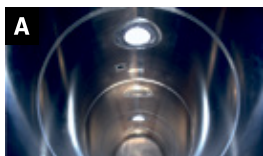
A Powierzchnia wewnętrzna silosu przechylnego
