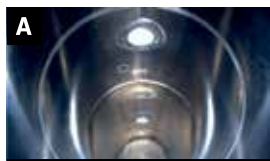
A Powierzchnia wewnętrzna siloś przechylnego
