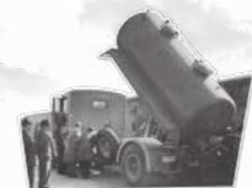
Nell'ottobre 1953, fu introdotto nel settore il primo semirimorchio per silo con sistema di ribaltamento idraulico. L'accoglienza positiva del mercato ha portato a un ulteriore sviluppo del prodotto per volumi più elevati. Nel 1955, il cassone ribaltabile aveva una propria linea di produzione dedicata nello stabilimento Kässbohrer di Ulm.
