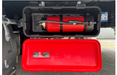
Apertura del armario de extintores
