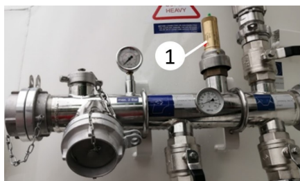
Válvula Limitadora de Presión
