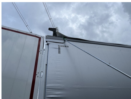
Elevación del techo desde el exterior
