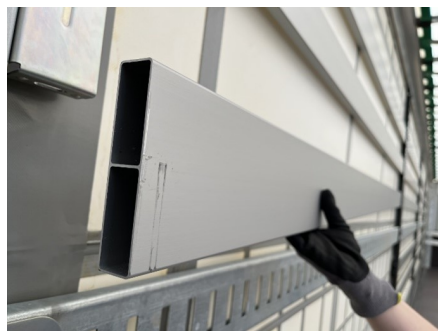
Estructura lateral de aluminio tipo caja
