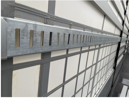
Estructura lateral de acero
