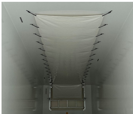
Conducto de ventilación
