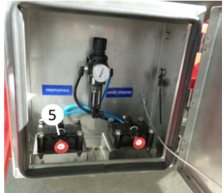
Pneumatischer Steuerkasten für die Entleerung
