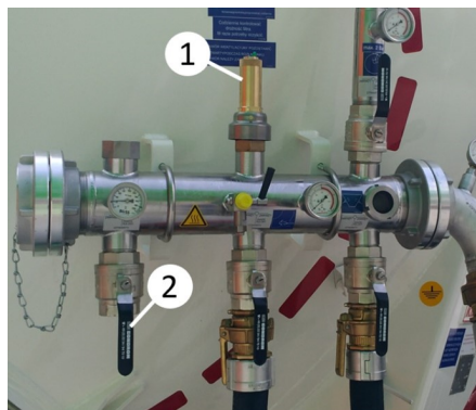
Válvula limitadora de presión y válvula de purga de aire
