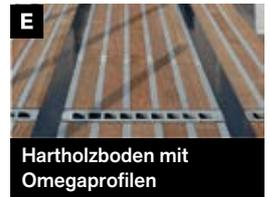
Hartholzboden mit Omegaprofilen
