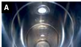
A Superficie interior del silo basculante
