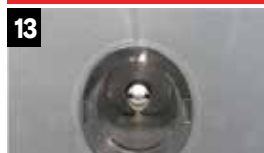
13 Aireación de descarga
