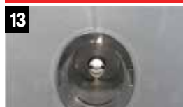
13 Aération du refoulement
