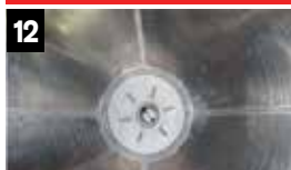
12 Aération du refoulement
