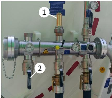
*Valvola di sovrappressione e valvola di rilascio dell'aria*
