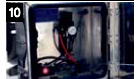
10 Wylądowanie pneumatyczne i górna linia powietrza
