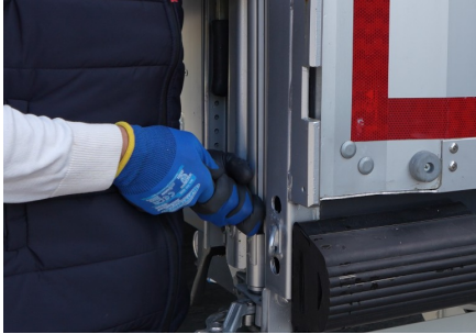
Desmontaje del perfil de la cortina
