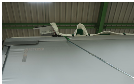
Elevación del techo desde el exterior
