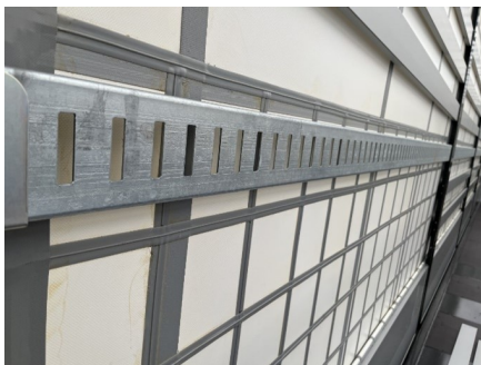
Estructura lateral de acero
