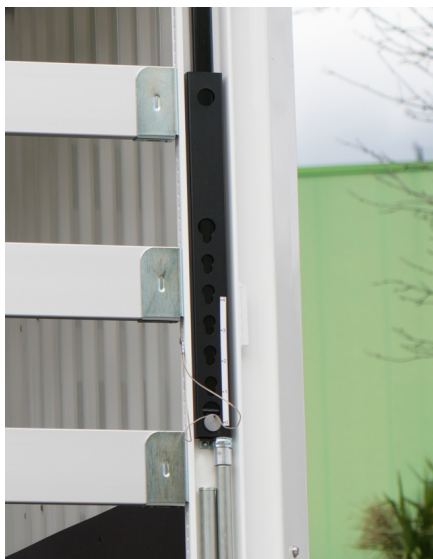
Barre de niveau pour le levage du toit
