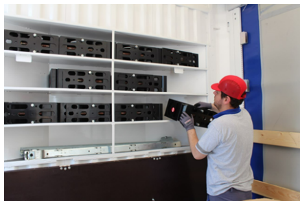
Stockage sur le panneau avant
