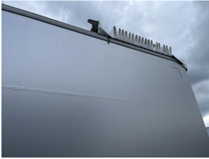
Levage du toit
