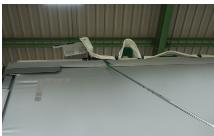
Levage du toit depuis l'extérieur
