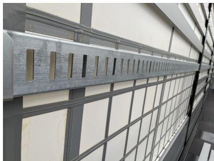
Structure latérale en acier
