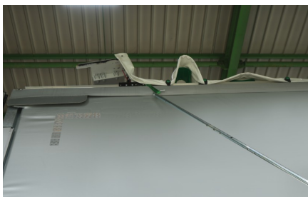
DPodnoszenie dachu od zewnątrz
