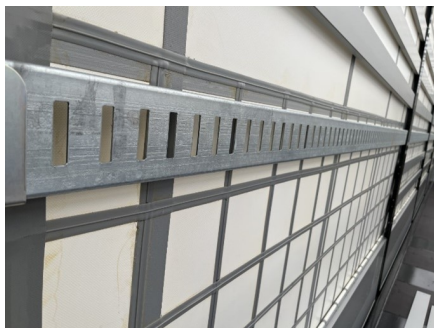
Stalowa konstrukcja boczna
