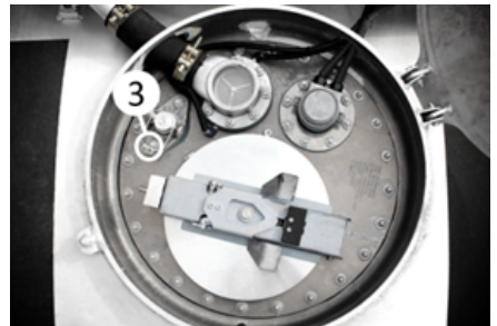
Ancrage de la tige de contrôle du niveau
