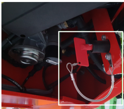
Interruptor de la batería
