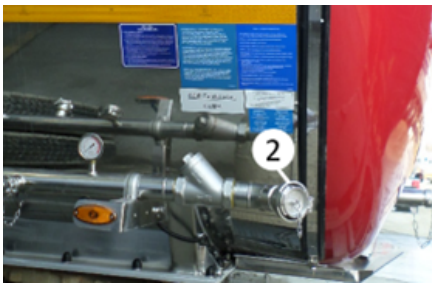
Conduite d'air latérale
