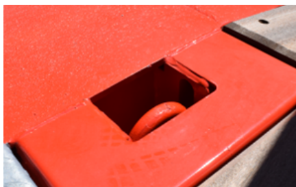
Anillo de aseguramiento de la carga enterrado
